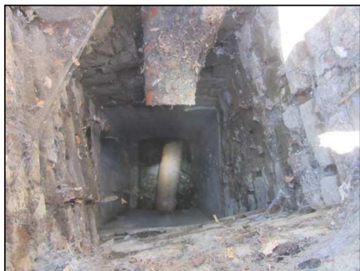
31. Šachta 3515684 – vybourání šachty, napojení na stávající PVC potrubí, vyzdění mezikruží
