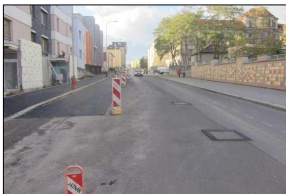
24. Viničná, poklopy šachty parovodu, osazení napojení na stávající vodovod
